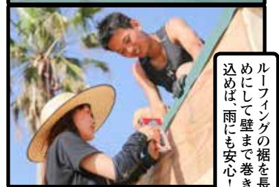
仕上げ材はホームセンターで安く買った「オンドュ波板」を使用。専用パッキンを波板の下に入れておけば、雨や虫の侵入を防げる
