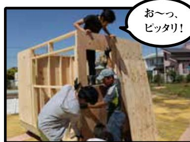
モバイルハウスは地面に固定しておらず、地面自体も水平とは限らないので、27ページのような下げ振りが使えない。なので、今回は合板の直角を利用して壁枠の水平・垂直を決めてみた
