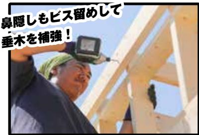
小壁の上に垂木をかけたとき、垂木と妻壁の上端がピッタリ合えばOK。この小壁の前面に構造用合板と鼻隠しを取り付け、さらにルーフィングを張って壁を仕上げれば、雨仕舞いは完璧！
