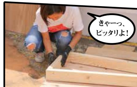
今回的小屋作りで一番の難関だったのが「妻壁」の枠の作製。どうしても斜め切りが多くなるので、合板に実物大の図面を描き、それに合わせて材料をカットしていくのが正解だった。ちなみに、妻壁の前面の高さを455mmとすると、屋根勾配は約2寸ほどになる
