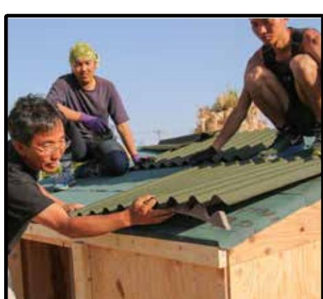
屋根の収め方は、実例①や②と同様。垂木に構造用合板12mmを45mmのビスで留め、アスファルトルーフィング、屋根仕上げ材の順で張っていく。今回は軒の出がないので、ルーフィングは妻壁まで少し包み込むようにして、雨の浸入を防いだ
