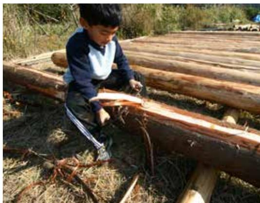
ログ材は作業前にピーリング（樹皮をむくこと）するのが基本。樹皮がついたままだと雨を吸って腐ったり、虫もつきやすくなる。加工時も樹皮がないほうが、墨付けをはじめとして作業がしやすい。電動カシナでむく方法もあるが、専用ナイフやカマでもむける。腕力ではなく体全体を使ってナイフを動かすことで疲労は少なくできる
