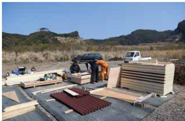
今回は敷地が広がったのでパネルの組み立て場所には困らなかったが、最初にプラットフォームを作れば、そこでパネルの作製ができる。また、自宅と建築場所が遠い場合は、自宅でパネルを作って、晴天時に現地に運んで一気に組み立てる方法もある
