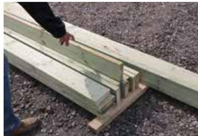
土台まわりに使用する2×6材は、すべて防腐処理されたもの。カットした面には、さらに防腐塗料を塗っておくと安心だ
