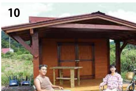
**用語解説** 方杖▶ほうづえ。垂直材(柱など)と水平材(桁など)を斜めに繋ぐ補強材のこと。
