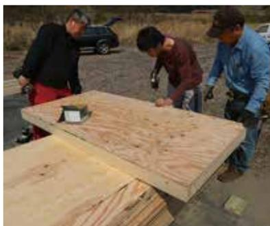
パネルの作り方は、図面通りに2×4材をカットして75mmのビスで枠組みし、その枠に構造用合板を45mmのビスで留めていくだけで簡単。また、すべてのパネルで縦枠はつねに長さ1,820mmとしておけば間違えにくい
