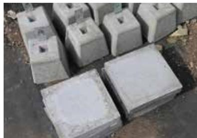
コーナー部には羽子板金具付きの沓石、その間にはコンクリート平板を置いて防腐処理材を基礎束として根太を支えた
