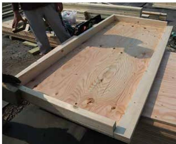
これは、コーナー用の**C**パネルを作っているところ。上下枠のツーバイ材に対して、どちらか片側のスタッドを平使い(平らに置く)している。このスタッドが、つねに**A**パネルの38mmのすき間にフィットして、かつ、**A**の内側にずらしたスタッドとピッタリ二枚重ねの状態ビス留めされることを頭に入れておこう!
