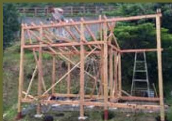
躯体は、一部を掘っ立て式にした軸組み構法。もちろん、これも自作できなくはないが、プロの大工に任せれば、強度的にはとても安心できる
