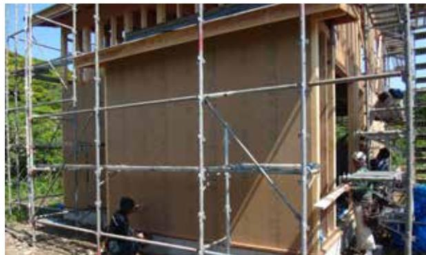
ハーフビルドした私の自宅では、面材スタイルを採用。ツーバイ構法と同じ感覚で作業できるので、セルフビルド向きだと思う
