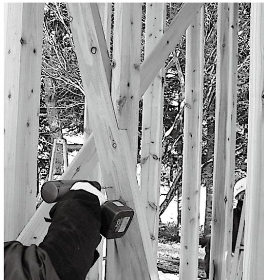
「筋交い」は軸組み構法を象徴する部材ではあるが、その加工精度や配置の方法によっては真価を発揮できないケースも少なくない
