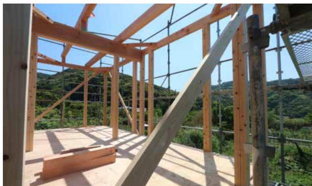
一見、複雑そうな軸組み構法だが、基本的なルールさえ覚えてしまえば、素人でも比較的簡単に建てることのできるのだ
