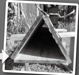
野地板を3枚組み合わせると三角柱を作り、濡らしたロープなどで結わえて仮止める
