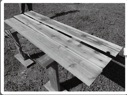
壁の仕上げ材はスギの野地板。これを表面だけ焼き焦がして「焼き杉」にする
