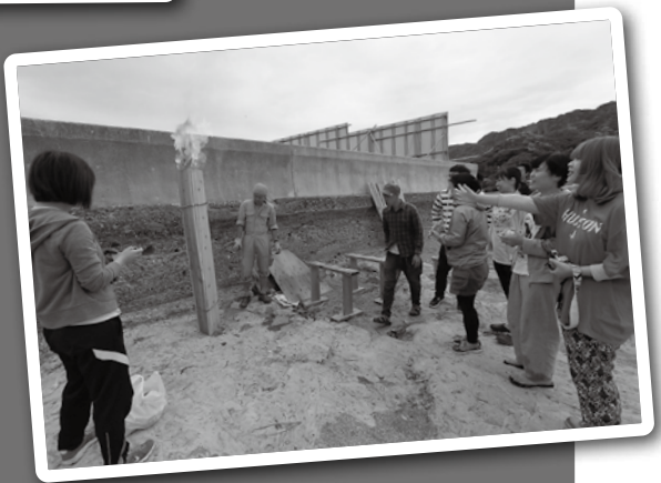
野地板を3枚組み合わせると三角柱を作り、濡らしたロープなどで結わえて仮止める
