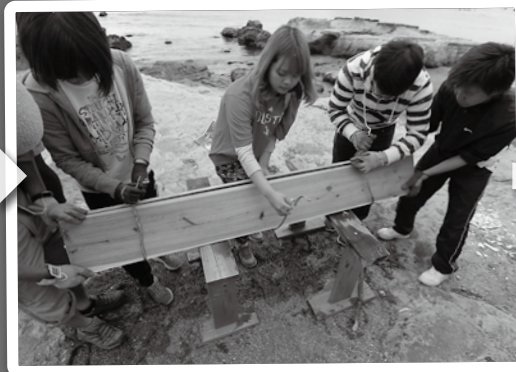
野地板を3枚組み合わせると三角柱を作り、濡らしたロープなどで結わえて仮止める
