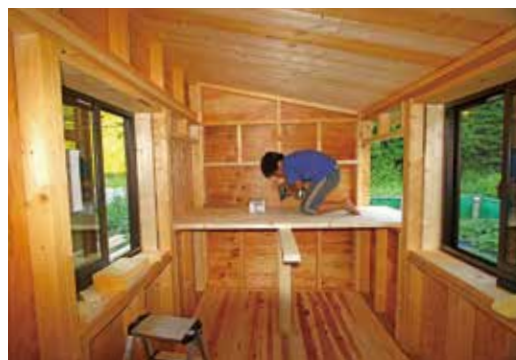
3畳小屋にバンクベッドを製作中の息子。室内空間は想像以上に広く、子供部屋にはジャストサイズだった
