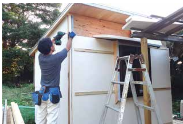
建築場所は我が家の裏庭。小屋のセルフビルドは、思い立ったらすぐに作業にとりかかれるのがうれしい。とくにツーバイ構法なら、素人でもほとんど失敗することなく小屋作りを楽しめる
